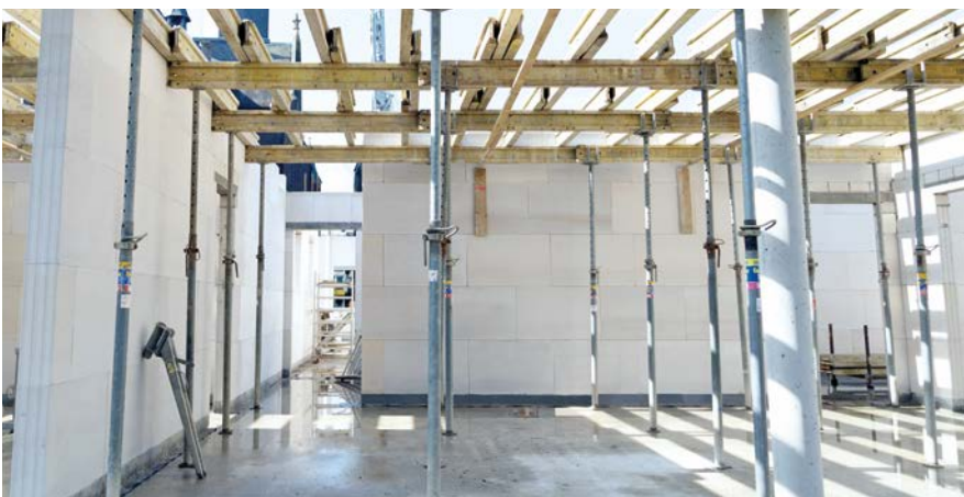
Bild 35 Kimmsteine in Querrichtung ausrichten
