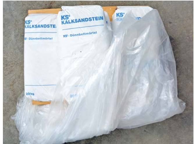
Bild 8 Der Werk-Trockenmörtel ist vor Witterungseinflüssen zu schützen.
