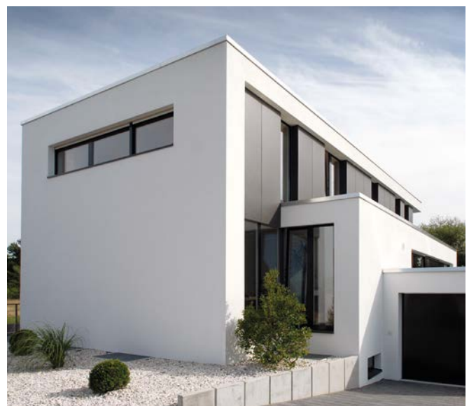
Bild 9 Verputzte Vormauerschale
