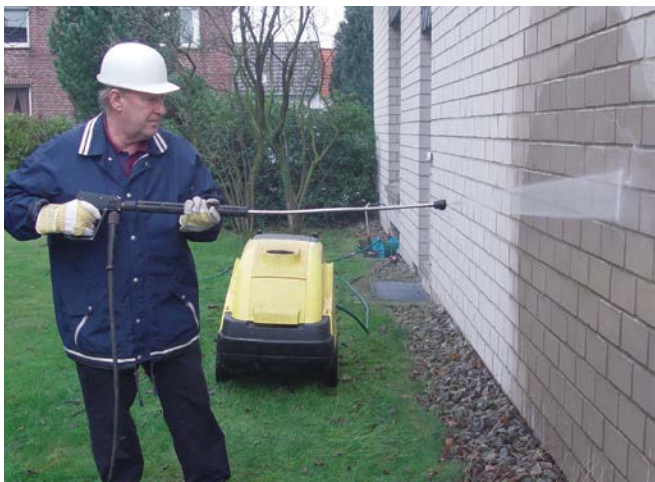
Bild 11 Reinigung mit Hochdruckreiniger mit ausreichendem Abstand zum Mauerwerk
