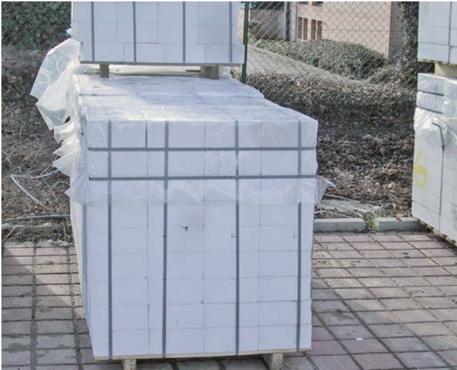
Bild 19 Lagern von Steinen mit Schutz gegen Niederschlag
