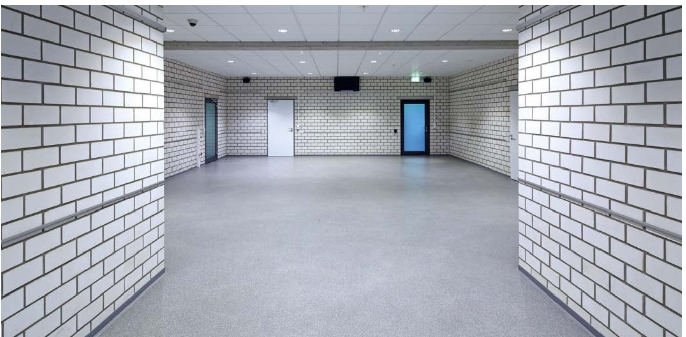
Bild 21 Halbstein-Überbindung minimiert Rissrisiko
