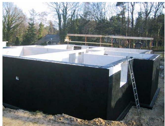
Bild 6 Kellerwand-Außenseite mit PMBC-Abdichtung
