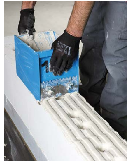
Bild 39 Auftragen des Mörtels für die Lagerfuge
