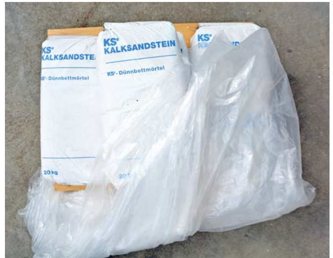
Bild 2 Der Werk-Trockenmörtel ist vor Witterungseinflüssen zu schützen.
