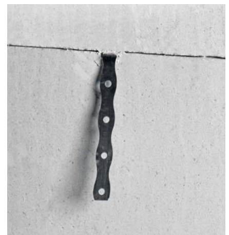
Bild 36 Stumpfstoßtechnik: Abgewinkelte Edelstahl-Flachanker (Bauphase) in Achse der anschließenden Wand
