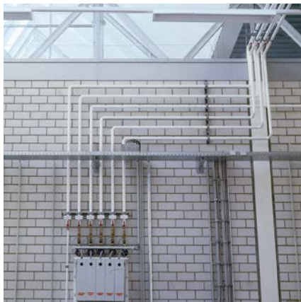
Bild 2 Innensichtmauerwerk aus Kalksandstein mit befestigten Installationsleitungen
