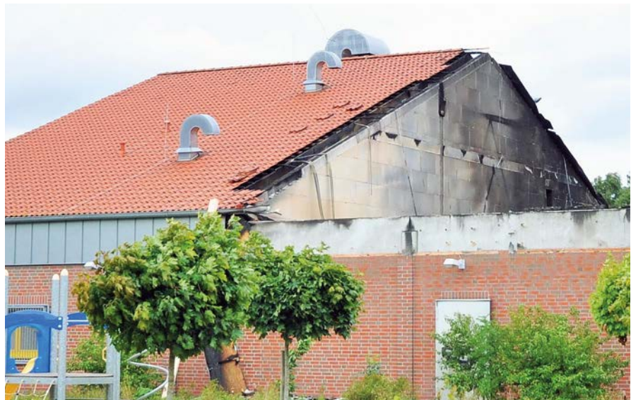
Bild 15 Eine Brandwand aus Kalksandstein-Mauerwerk hat die Brandausbreitung auf weitere Gebäudeteile verhindert.
