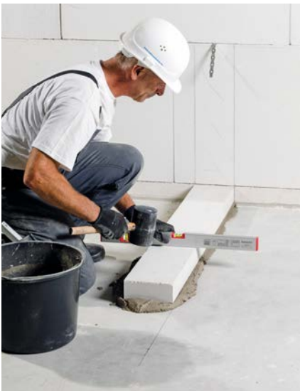
Bild 35 Kimmsteine in Querrichtung ausrichten
