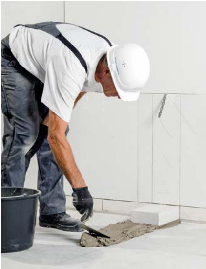
Bild 33 Mörtel auf die Betonsohle auftragen
