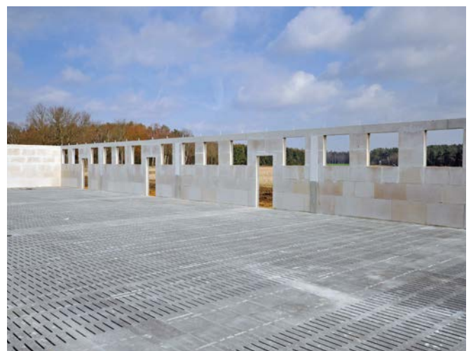
Bild 49 Rohbau eines Maststalls
