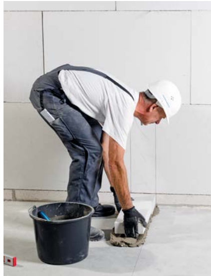
Bild 34 Kimmsteine ins Mörtelbett verlegen
