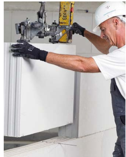
Bild 42 Versetzen der folgenden Elemente
