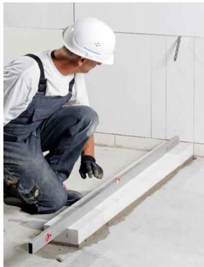
Bild 36 Kimmsteine in Längsrichtung ausrichten
