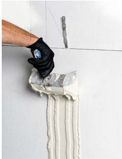
Bild 38 Mörtel für Anschlussfuge auftragen
